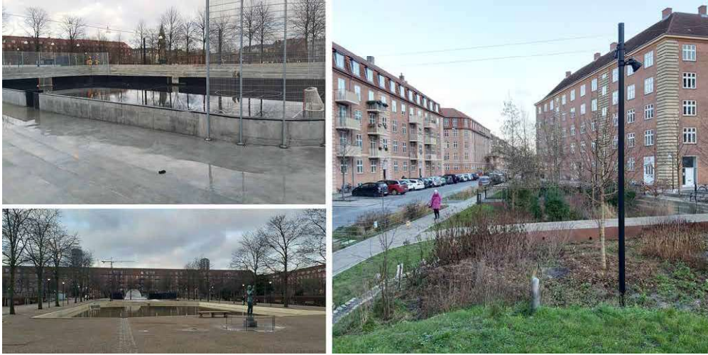
Kuva 7. Kuvat vasemmalla: Enghave-puistossa, Kööpenhaminassa (valmistunut syksyllä 2019), urheilukenttää on laskettu 3 metrin syvyydelle mahdollistaen tulvavesien varastoimisen. Puiston vanhaa allasta on myös muokattu niin, että vesiä voi ohjata altaaseen rankkasateella. Yhteensä puistossa voi varastoida 24 000 m 3 . Kuva oikealla: Täsinge plads on Kööpenhaminan ensimmäisiä tulvarakenteita (valmistunut 2014) ja on saanut paljon huomiota myös kansainvälisesti. Puistossa voi varastoida noin 7 000 m 3 .
